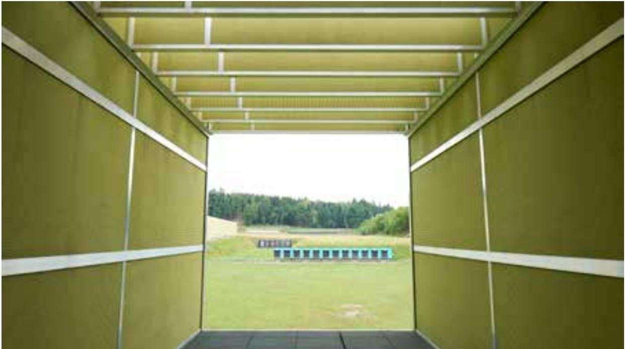
*Abb. 20: Schallschutzwand mit Fächer oben*
