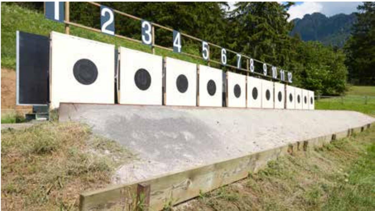
Abb. 40: Vorkugelfang Sand mit montierter Prellplatte
