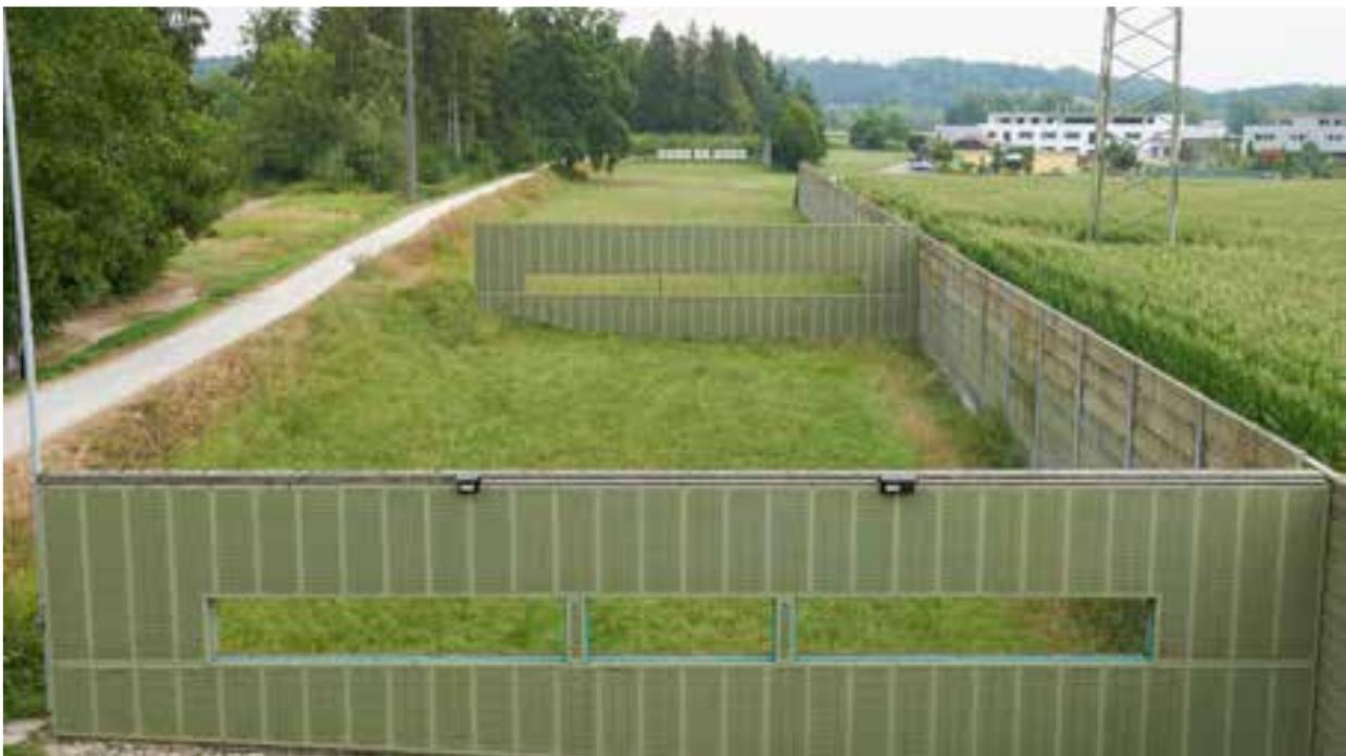
Abb. 59: Betontief- und Betonhochblende
