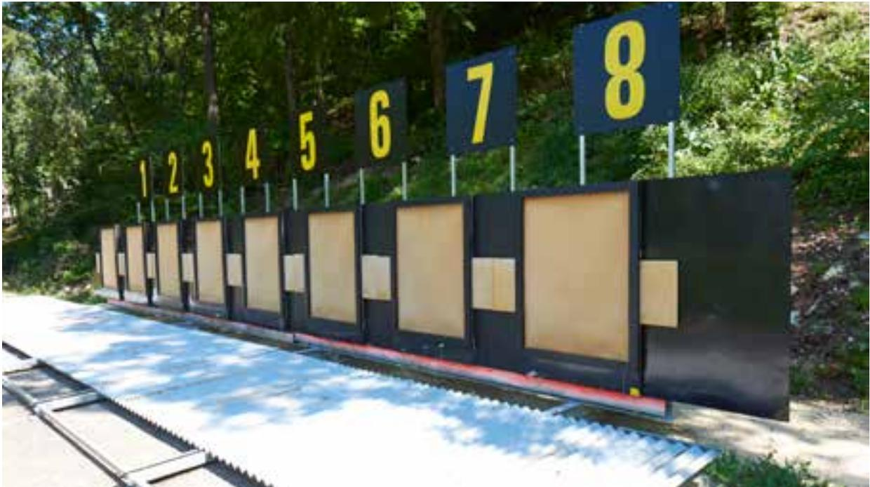
Abb. 47: Kugelfangsystem Frontansicht Variante Berlin
