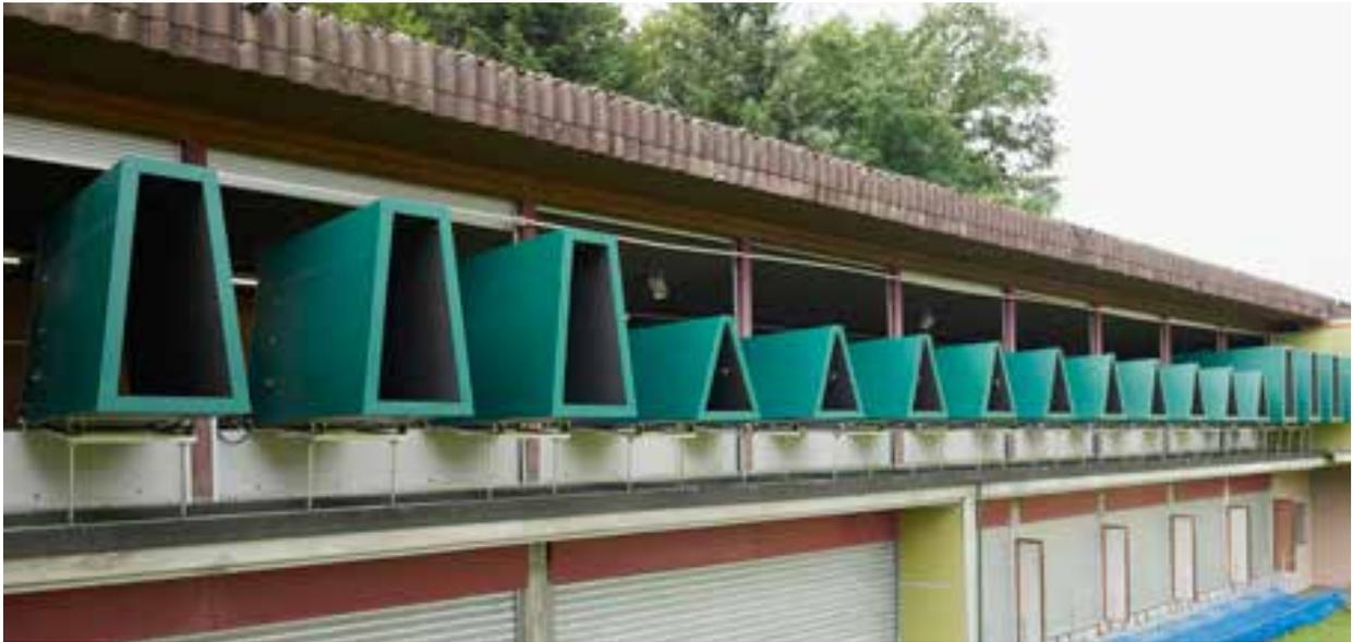
Abb. 23: Schallschutztunnel (dreieckig)
