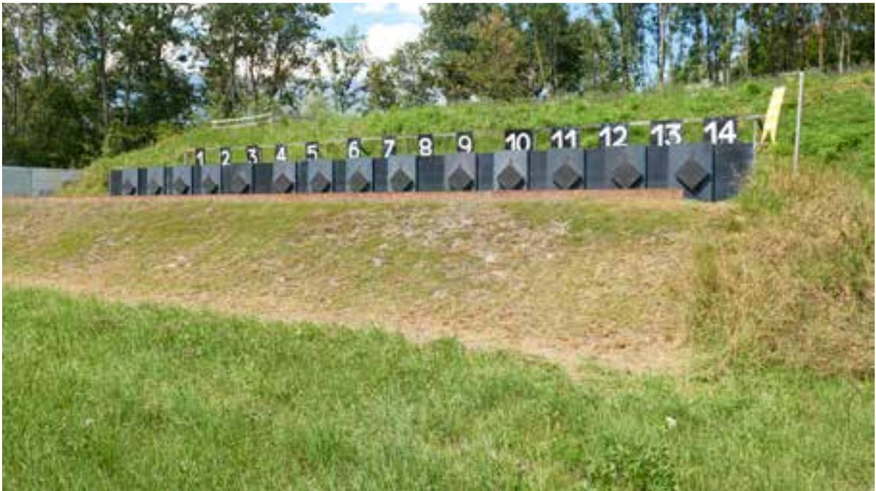
*Abb. 39: Vorkugelfang Erde mit montierter Prellplatte*
