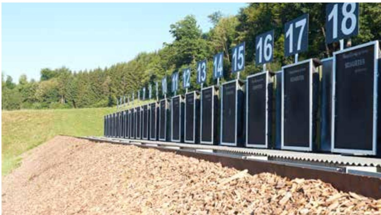
Abb. 46: Kugelfangsystem Frontansicht Variante MaRep
