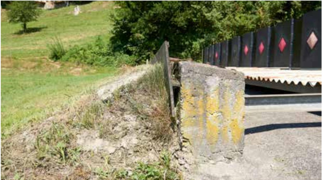
*Abb. 38: Ansicht der montierten Prellplatte*
